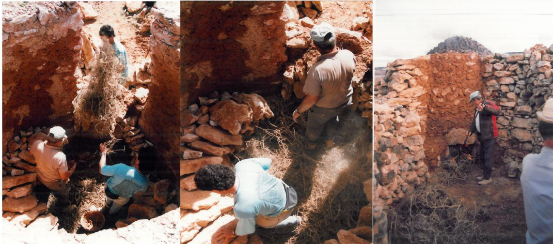
Figura 2. De izquierda a derecha: carga inicial del horno, releje cubierto de aulagas y calero añadiendo combustible al horno. (Fotos cedidas por el Archivo Histórico del Cabildo de Fuerteventura).
