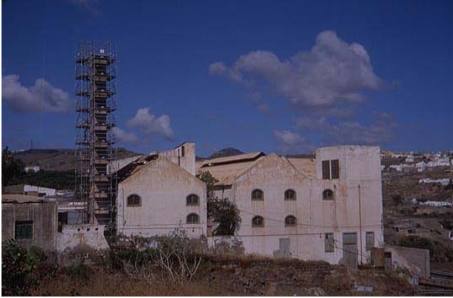
Il. 3.- Exterior de la fábrica, con la chimenea durante el proceso de restauración.
